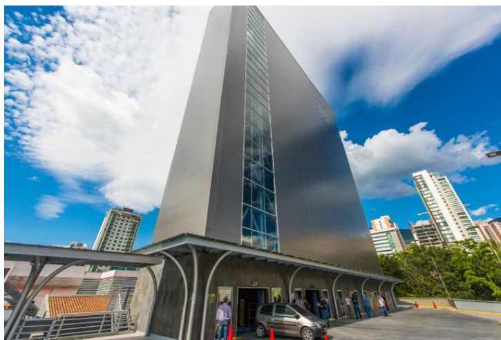
Figura 33. Torre parqueaderos robotizada centro comercial Oviedo
