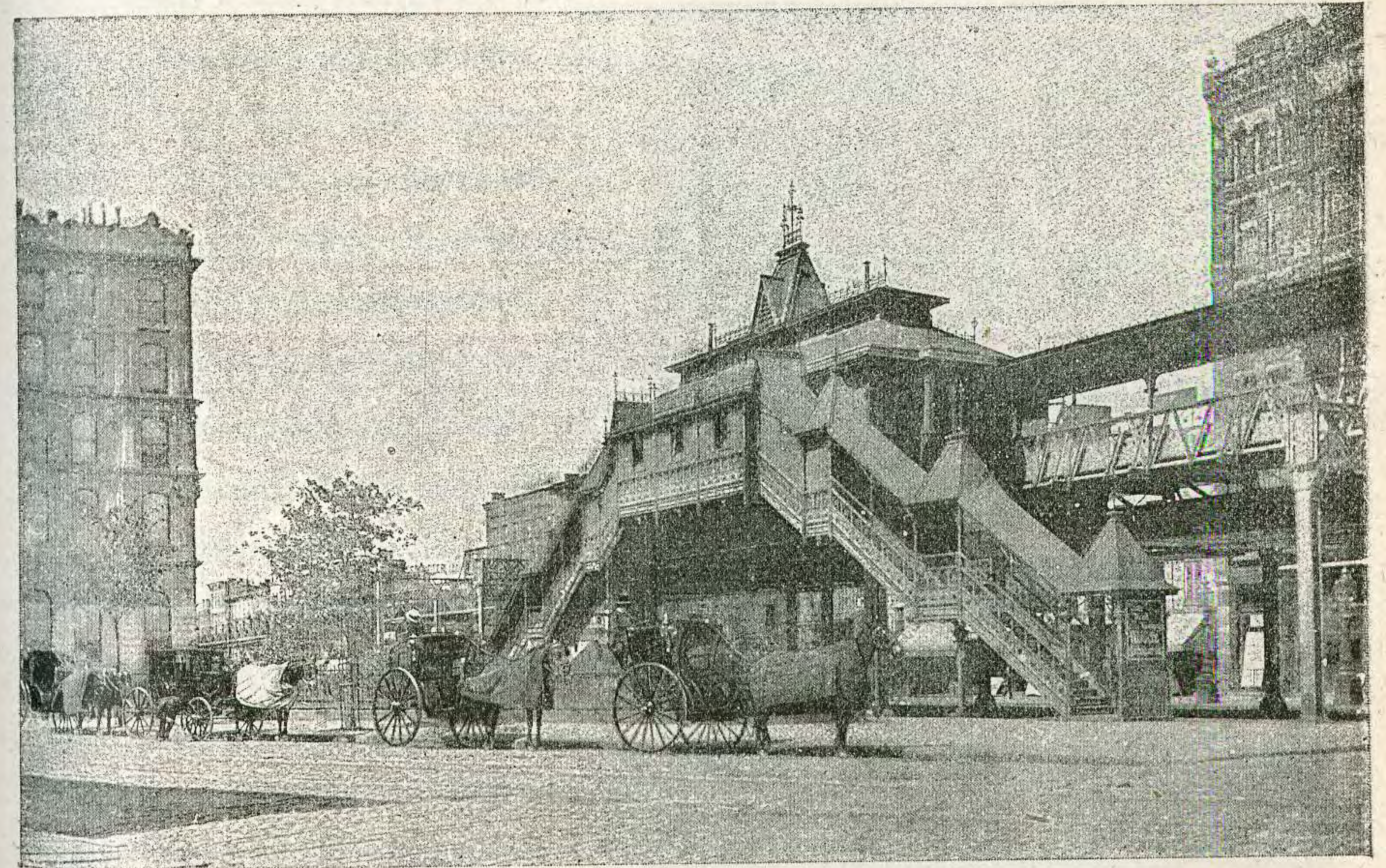
Una estación de ferrocarril elevado en Nueva York
