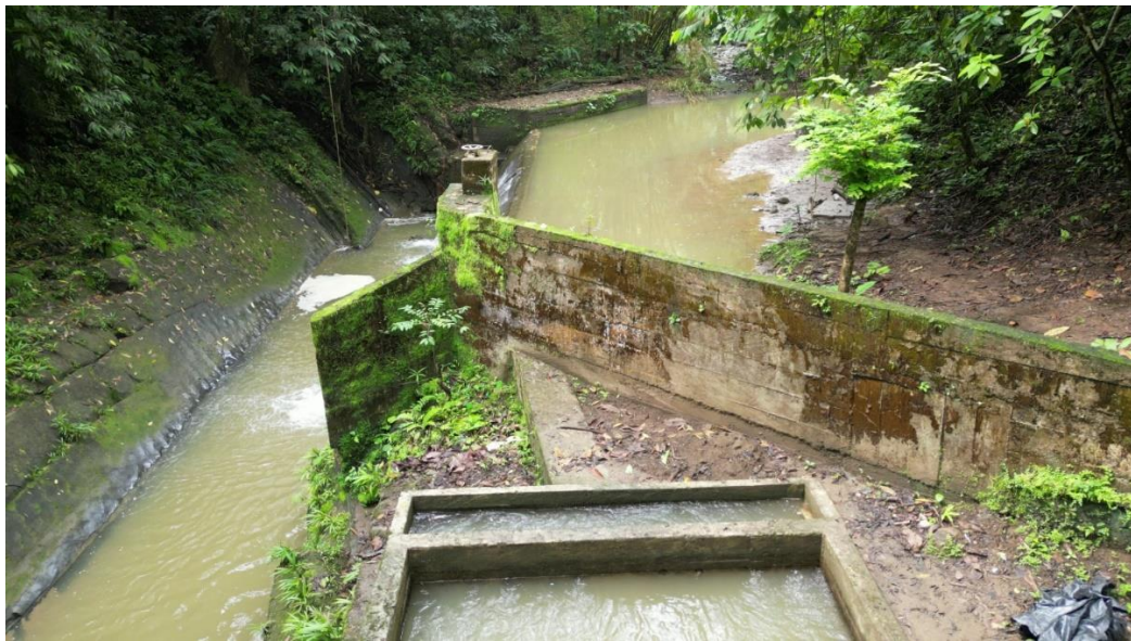
Figura 61. Bocatoma del acueducto que sirve a Nueva Colonia. Vereda El Salto, Apartadó. Fotografía: Diego David Sierra Gutiérrez, 2025.
