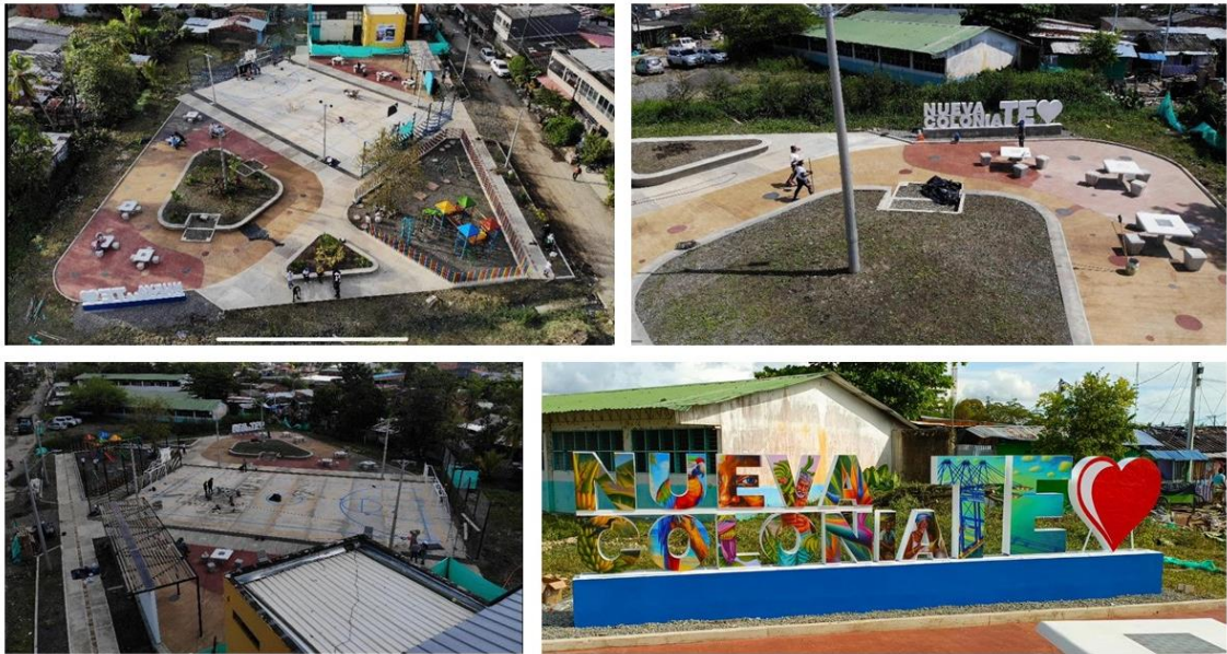
Figura 63. Parque de la Alegría. Barrio 24 de Diciembre, Centro urbano corregimiento Nueva Colonia. Foto: Cortesía DCI Arquitectos (firma constructora). 2025.
