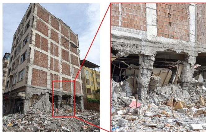
Figura 9. Daños severos causados por configuración de piso débil durante el sismo de Turquía, 2023. Tomado de ReLUIS – EUCENTRE (2023).
