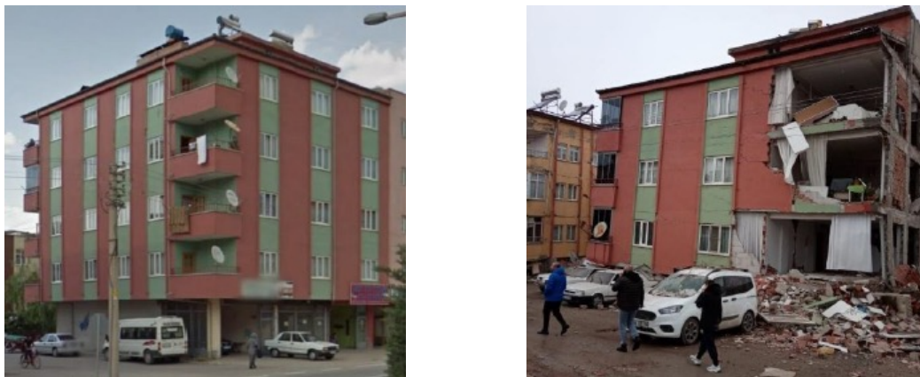
Figura 23. Colapso de edificio de 5 niveles por piso débil. Izquierda: previo al evento; derecha: después del evento.
