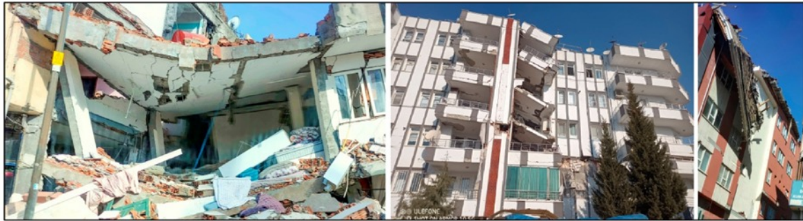
Figura 19. Colapso suspendido.
