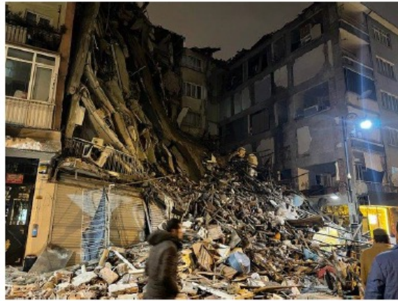
Figura 21. Edificio colapsado y evidencias de que no existe separación sísmica entre edificios adyacentes.
