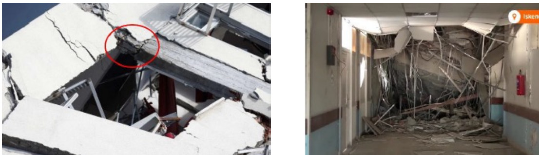
Figura 25. Daño estructural (izquierda) y no estructural (derecha) en un bloque de hospital. El daño estructural evidencia barras de acero con corrosión. El daño no estructural muestra que, aunque el exterior del edificio puede permanecer sin daño o con daño leve, en el interior puede existir daño significativo que afecta la funcionalidad de la edificación.
