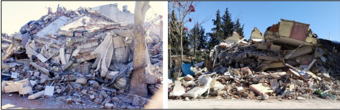
Figura 18. Colapso con amontonamiento de escombros.
