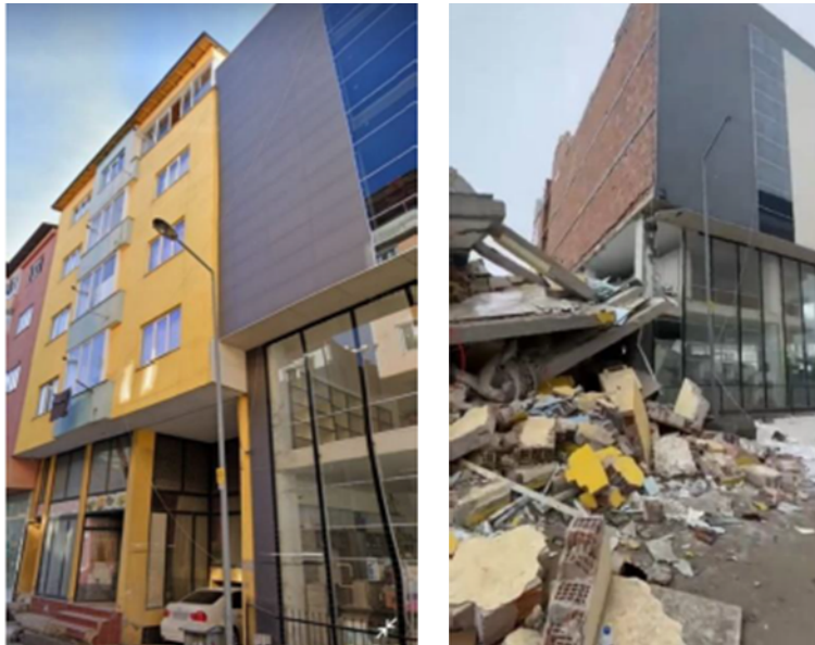
Figura 20. Colapso de edificio de 5 niveles por piso débil. Izquierda: imagen previa al evento; derecha: imagen después del sismo.
