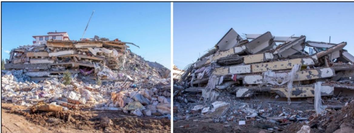
Figura 17. Colapso tipo "pancake" o apilamiento.
