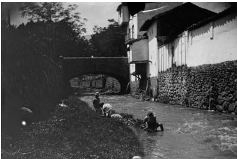
Imagen 35. Quebrada Santa Elena antes de ser cubierta.
