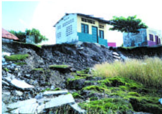
Figura 14. Deslizamientos gravitacionales y flujos de lodos en materiales fuertemente meteorizados, inmediatamente al norte del volcán de lodos.
