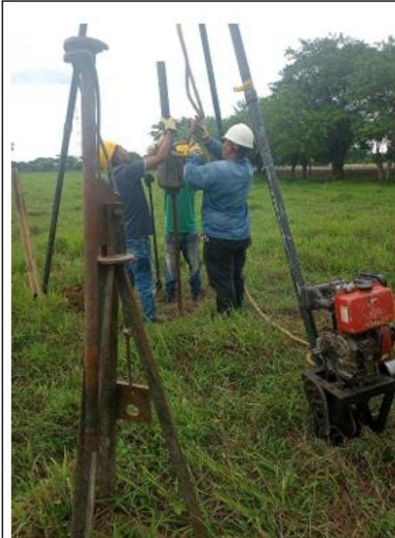
Fotografía 1. Se realiza SPT con avance a percusión para el Sondeo 1 muestra 1, coordenadas Norte 8°45'53.32" y este 75°50'21.29.
