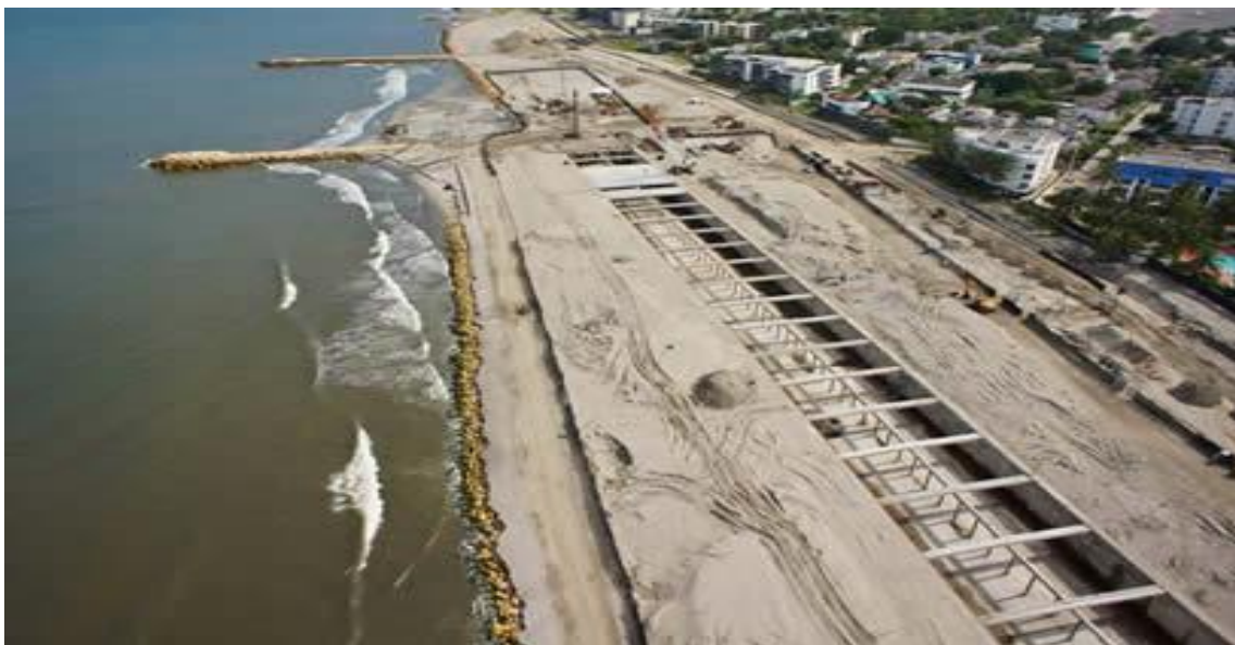
Imagen 16. Anillo vial en construcción, Fuente: Google Imagen.
