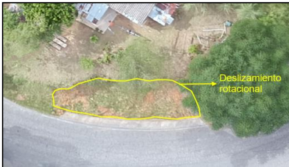
Figura 30. Ortofotografía donde se identifica deslizamiento rotacional, hacia el centro-occidente del área de estudio, sobre la vía Medellín-Cisneros. Proceso activo.
