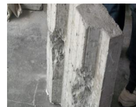
Figura 26. Probeta #5. Superficie de falla en el concreto.
