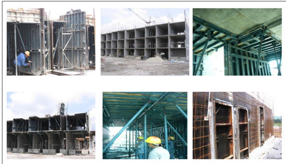
**Figura 1.** Sistema tipo túnel. PCG SYSTEMS.
