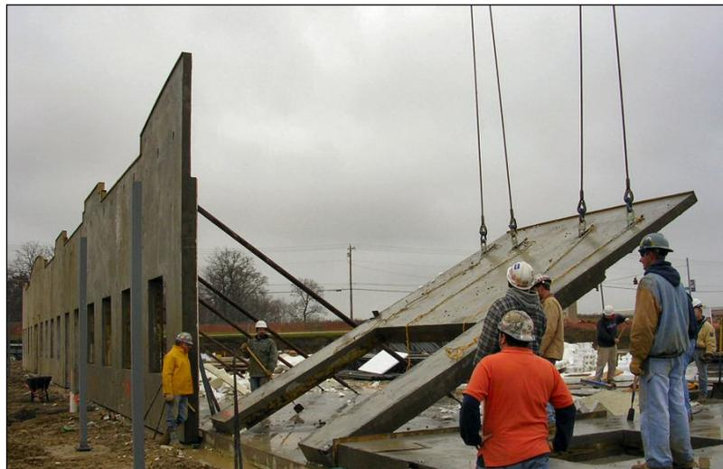
**Figura 3.** Sistema Tilt-Up. QUADLOCK.
