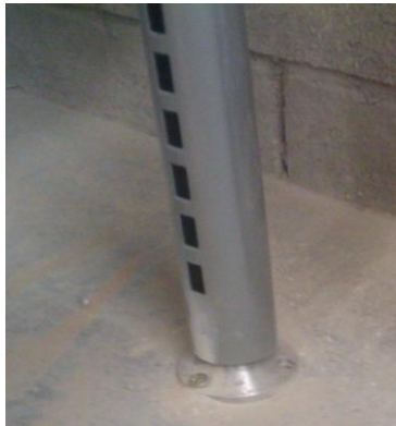
Foto 71. Sujeción a piso del paral
