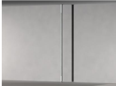
Foto 18. Paral Autopol piso a techo
