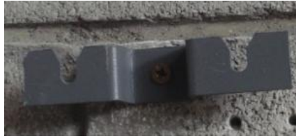
Foto 80. Detalle soporte cremallera escondida
