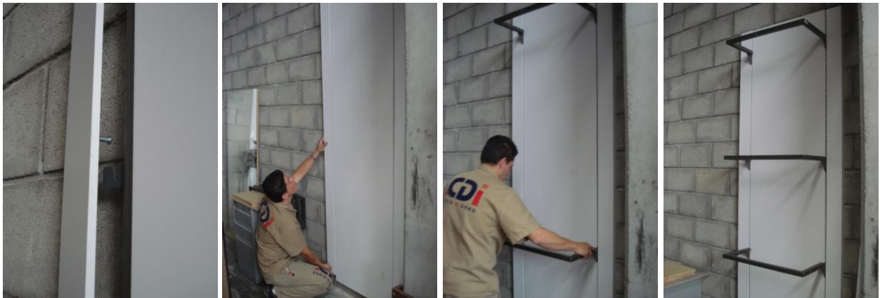
Foto 84. Secuencia 3 de armado
