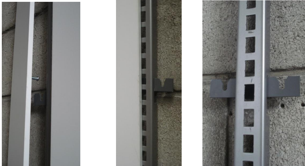
Foto 74. Detalle 1 anclaje a pared cremallera
