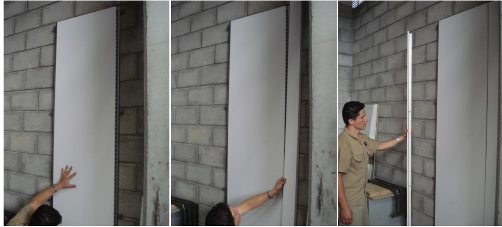
Foto 83. Secuencia 3 de armado
