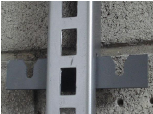
Foto 77. Detalle nuevo anclaje
