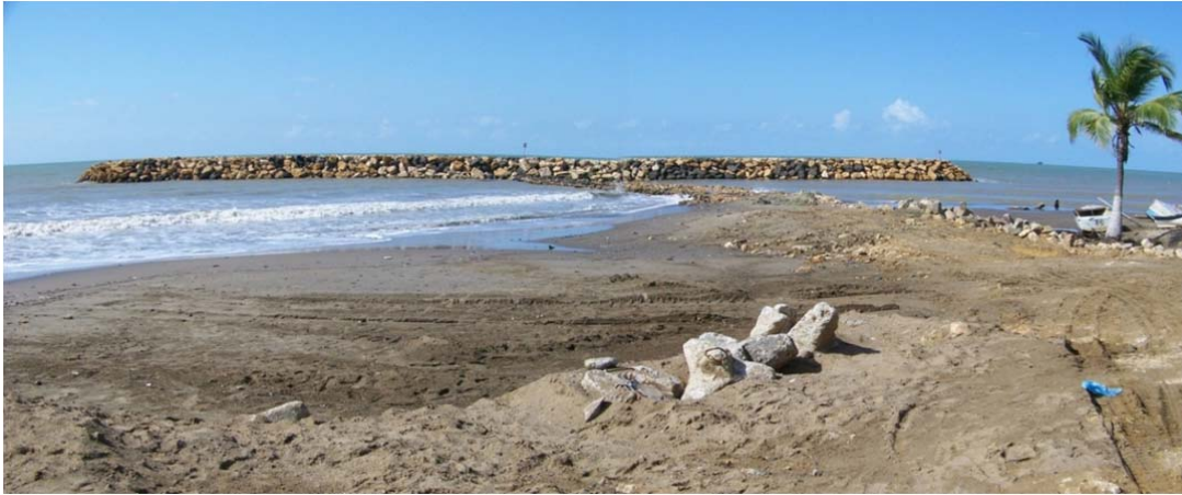
Figura 36. Estructuras de protección costera que están siendo construidas en Arboletes. Foto: JPrüssmann – 8 de noviembre de 2010.
