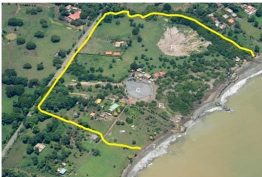
Figura 48. Panorámica del Volcán de lodo de Arboletes. La línea amarilla denota los límites de la estructura cómica. C: Cráter – FL: Flujos de lodo – T: Terraza elevada con acantilado. Foto: Aeroestudios S. A.
