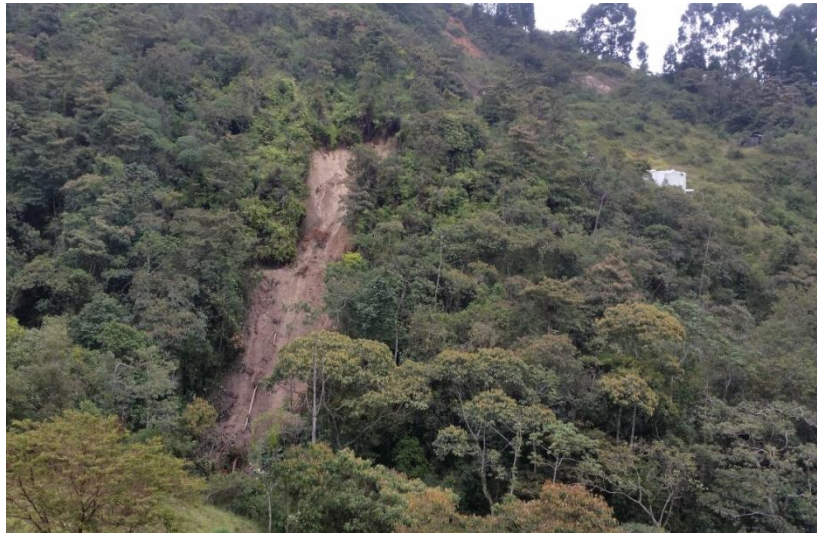
Ilustración 27. Deslizamiento traslacional cerca de la planta de tratamiento de agua del sector Pueblo Viejo.
