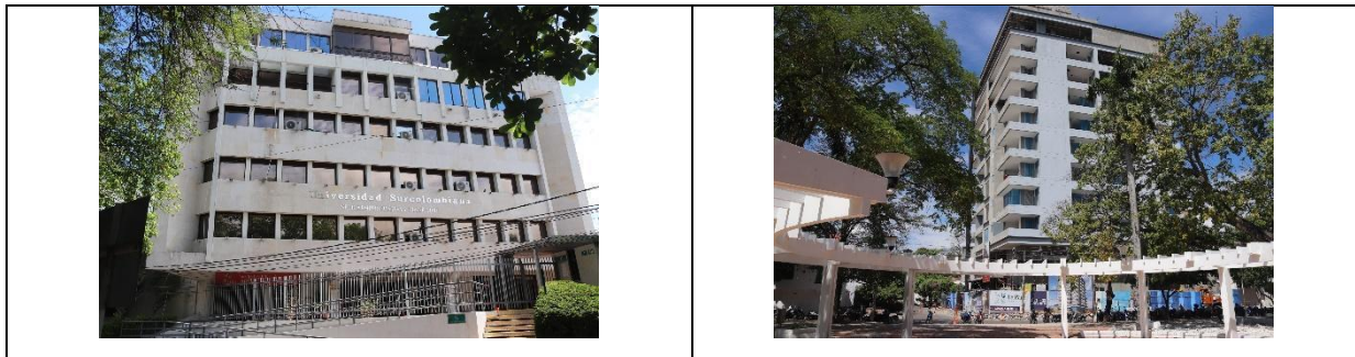
Foto 12: Edificio de Postgrados - USCO Foto 13: Le Parc
