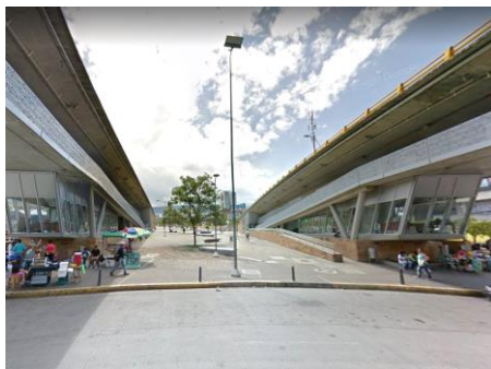
Imagen 54: Cra. 15 – Av. Quebrada seca
