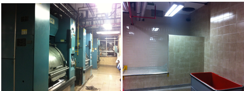
Ilustración 3. Zona de lavado y recepción de ropa sucia
