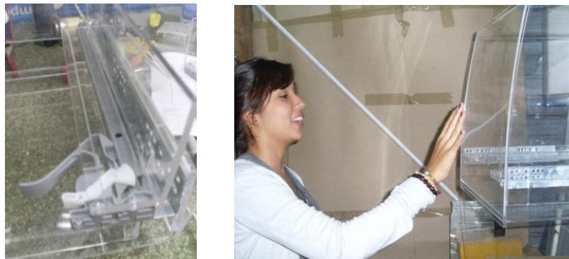
Imagen 2. Instalación de rieles
