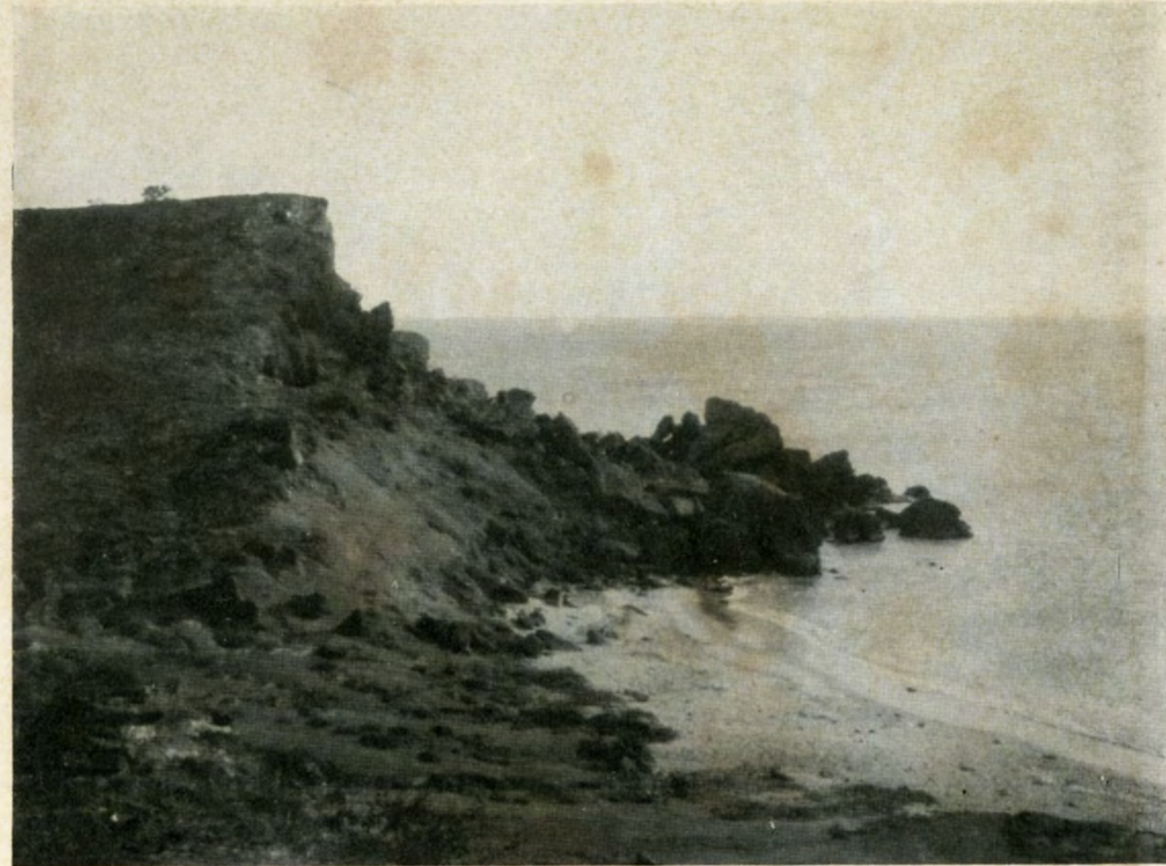
Das Westende an der Ostseite des Eingangs zur Bahiahonda. Blick in die Bucht. Abgestürzte Sandsteinfelsen. Hier legt das Postboot an. 4. Mai 25.
