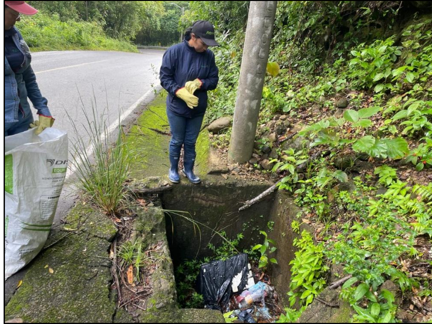
Vía vereda Cabañas
