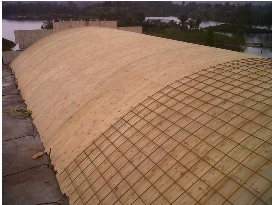
Figura 16. Forma de cúpula real con la ayuda de formaletería en madera
