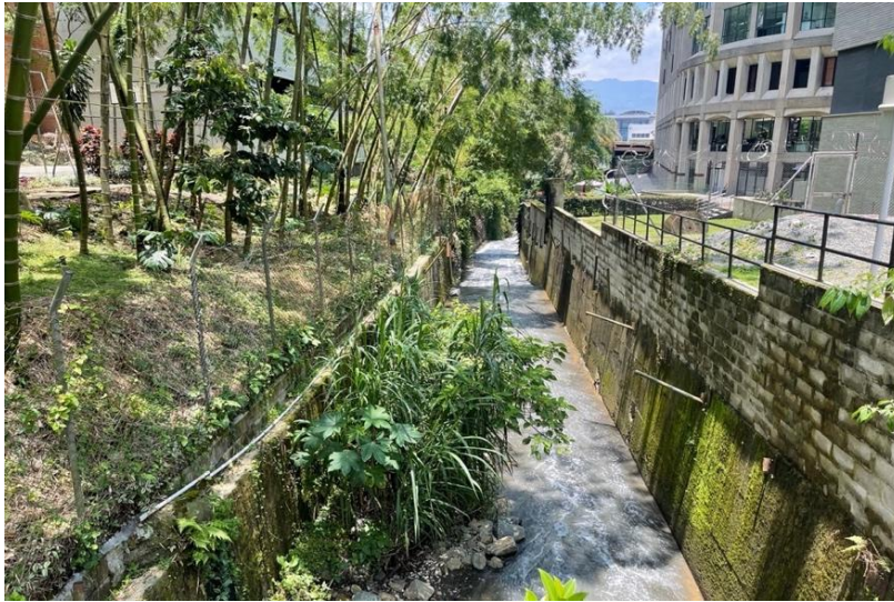
Figura 33. Quebrada La Volcana en el Tramo del Centro Comercial Río Sur.
