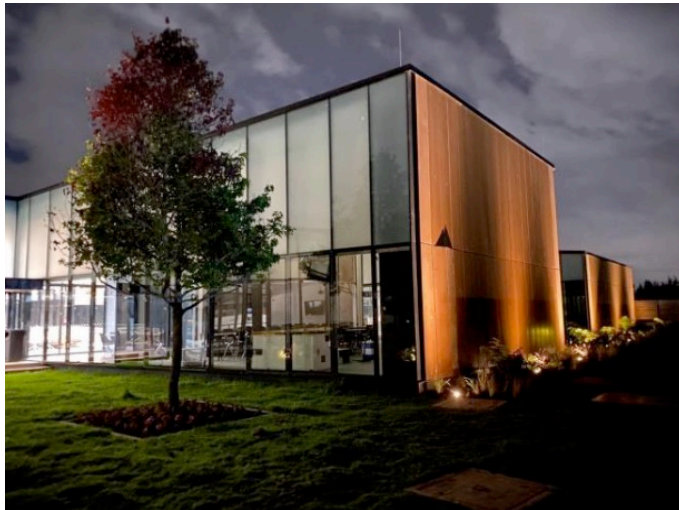
Figura 18. Infraestructuras Sostenibles, Universidad del Rosario
