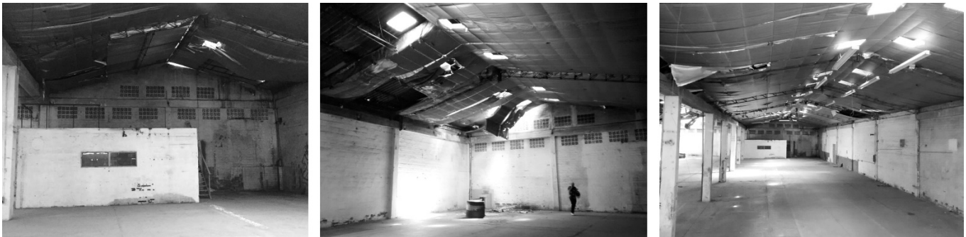
Ilustración 28: Registro fotográfico interior de la bodega existente. Elaboración propia.
