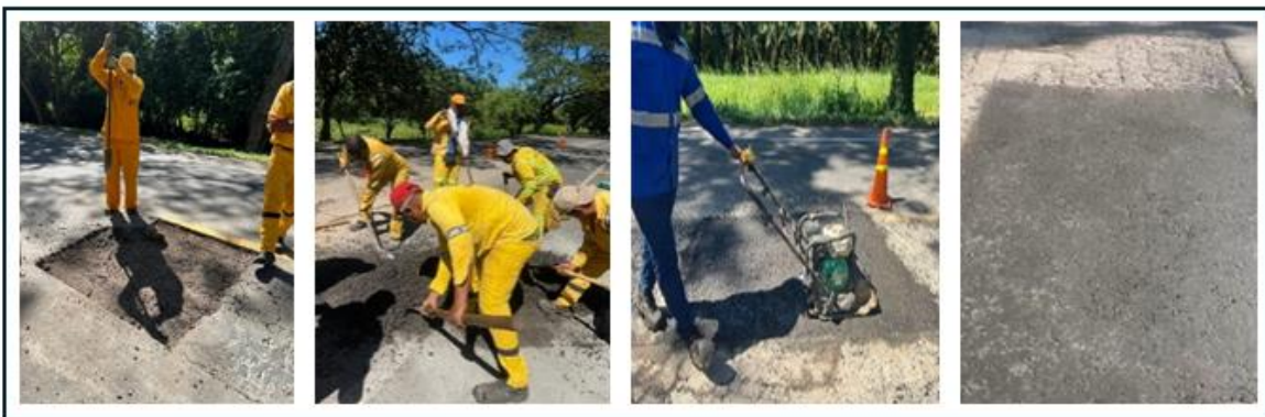
Imagen 2. Parcheo en campo tramo 1.
