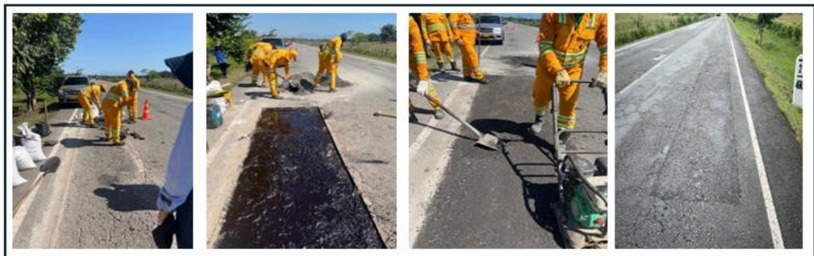
Imagen 4. Parcheo en campo tramo 3.
