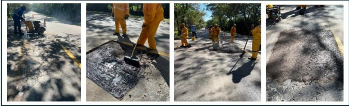
Imagen 3. Parcheo en campo tramo 2.
