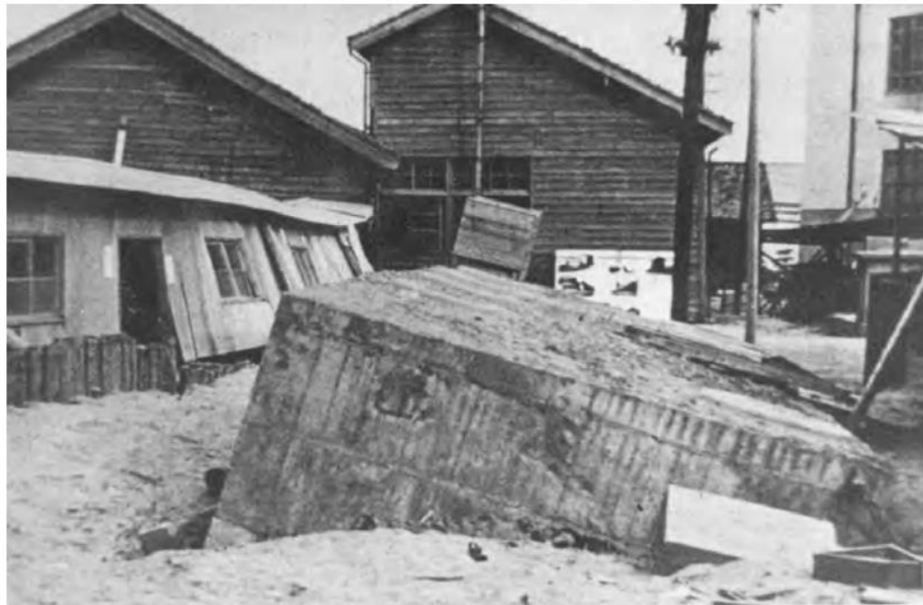
Ilustración 2. Flotación de tanques enterrados en suelo licuado - Terremoto de Niigata (1964)
