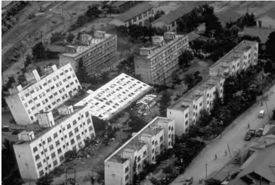
Ilustración 1. Inclinación de edificios causada por licuación - Terremoto de Niigata (1964)
