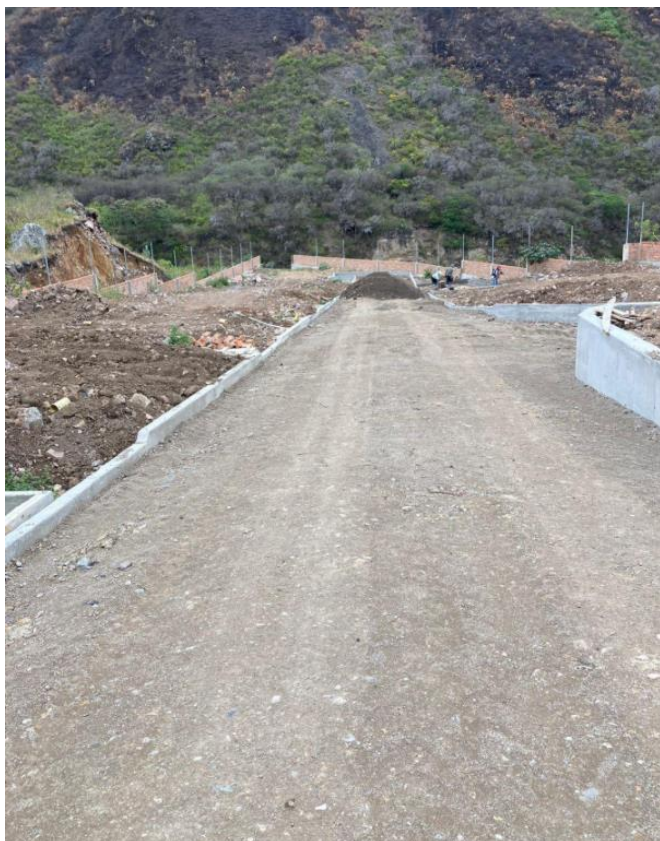
Figura 5. Avance de construcción de vías internas y bordillos en el Portal del Capulí
