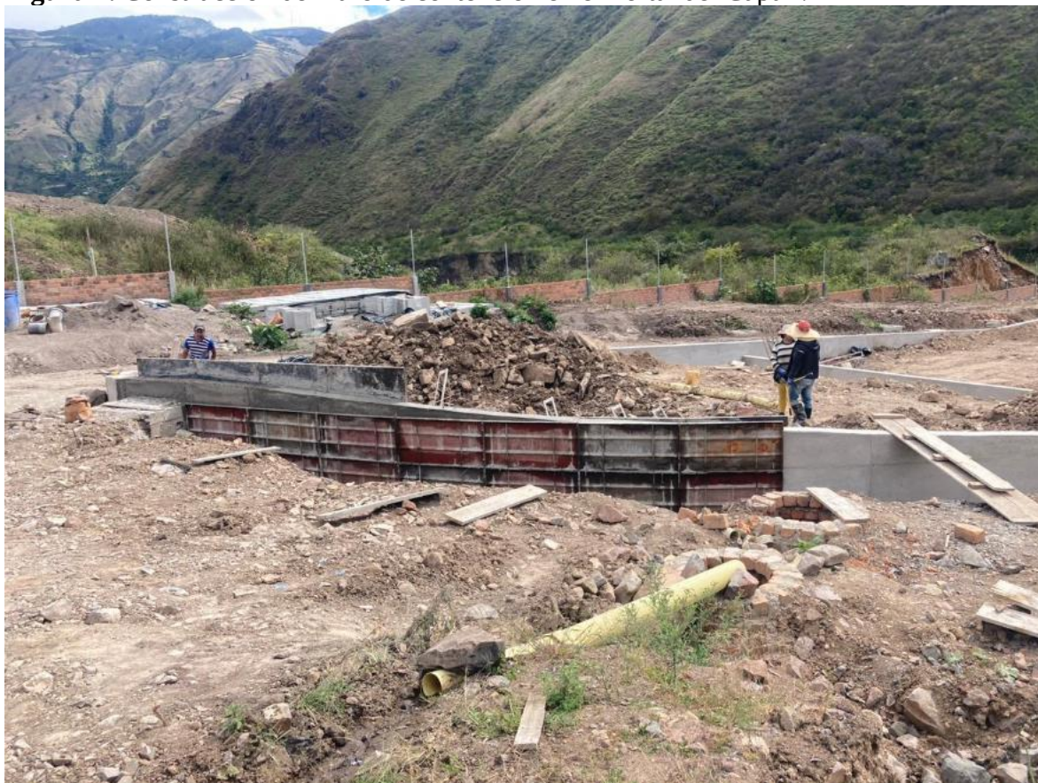
Figura 7. Construcción de muro de contención en el Portal del Capulí.
