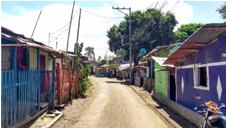
Ilustración 32. Vía actual dentro de la Banca del Ferrocarril
