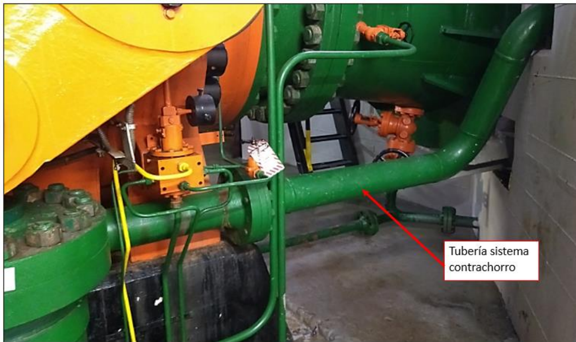
Figura 21. Sistema contrachorro dimensionado
