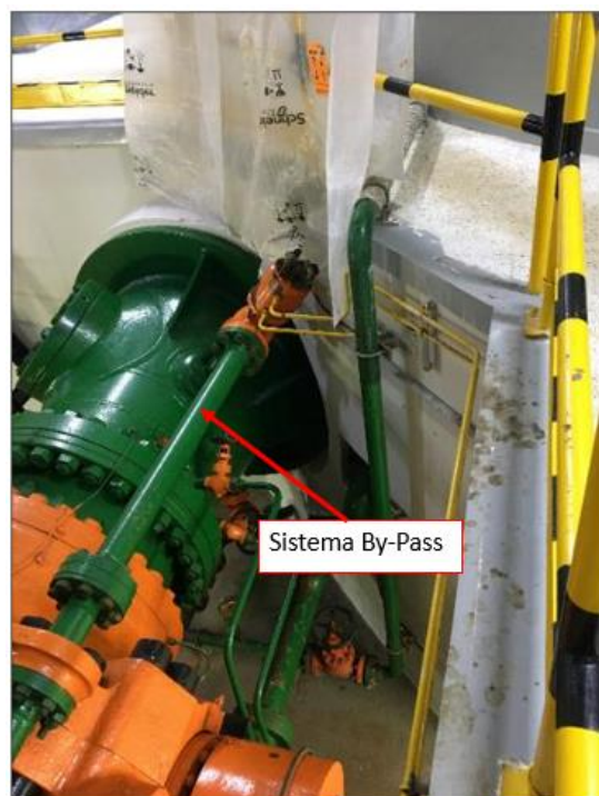
Figura 18. Sistema By-Pass Dimensionado
