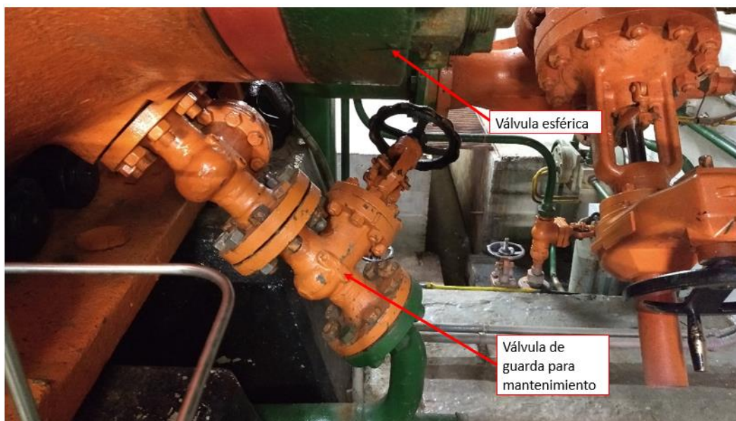
Figura 19. Sistema de drenaje en la válvula esférica
