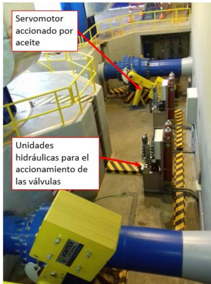
Figura 13. Sistema de mando hidráulico. Tomado de (Vortex Hydra Innovation & Engineering, 2022)
