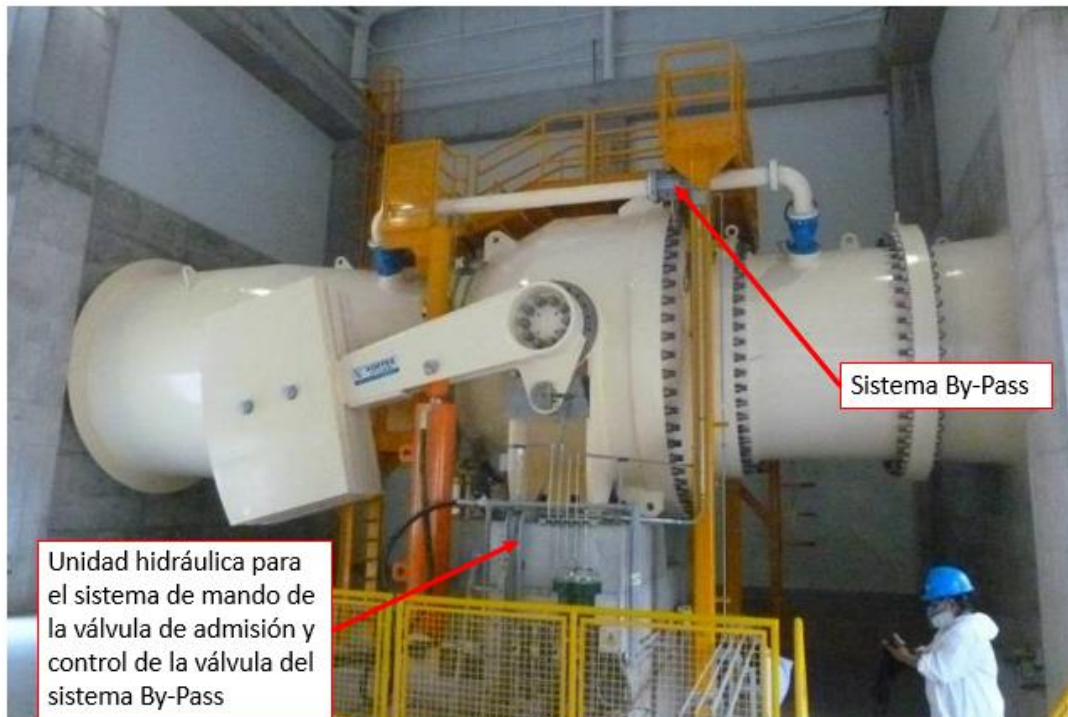
Figura 9. Válvula esférica con Bypass Vortex Hydra Valves Tomado de: (Vortex Hydra Innovation & Engineering, 2022)
