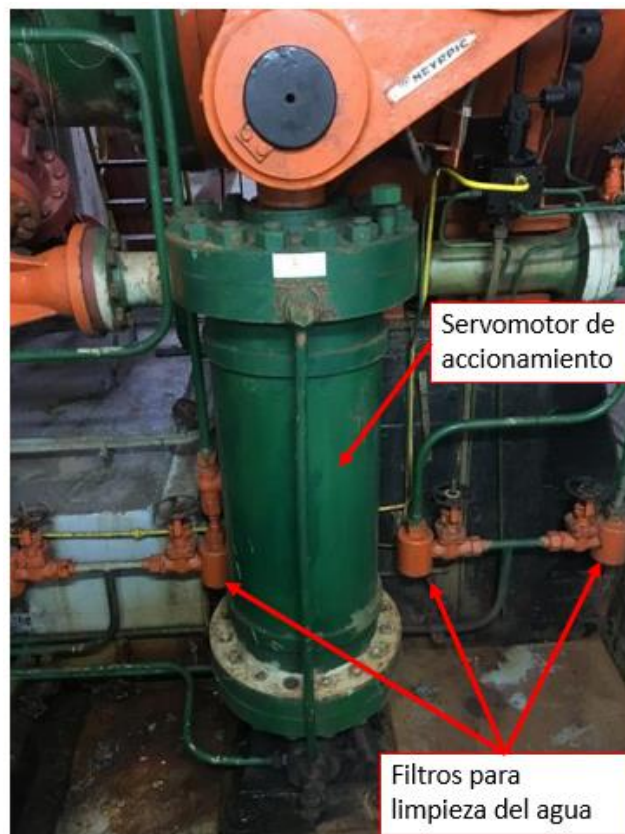
Figura 23. Servomotor dimensionado.
