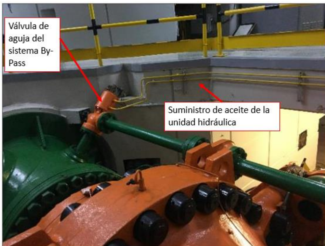
Figura 17. Sistema By-pass dimensionado
