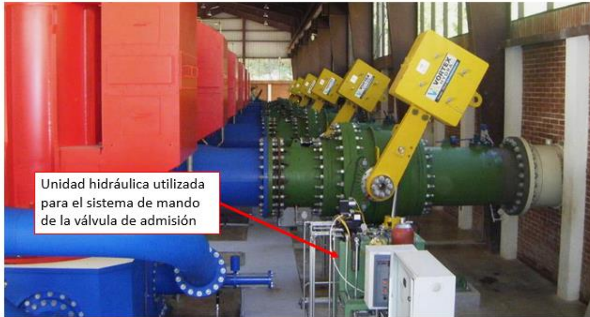
Figura 6. Válvulas esféricas con contrapeso Vortex Hydra Referencia: (Vortex Hydra Innovation & Engineering, 2022)
