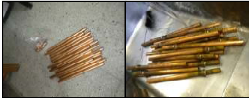
Ilustración 26. Corte y limpieza de los tubos de calor
