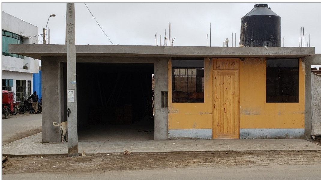
Figura 35. Módulo de vivienda ampliado del programa Techo Propio en Chilca
