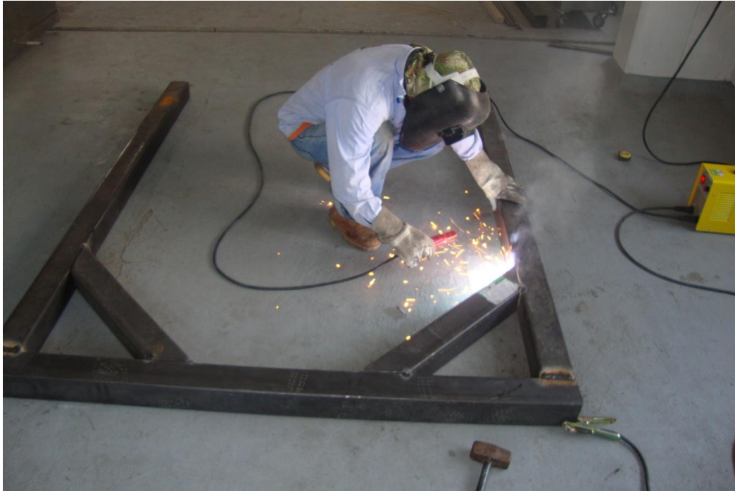
Figura 42. Construcción de torre.
