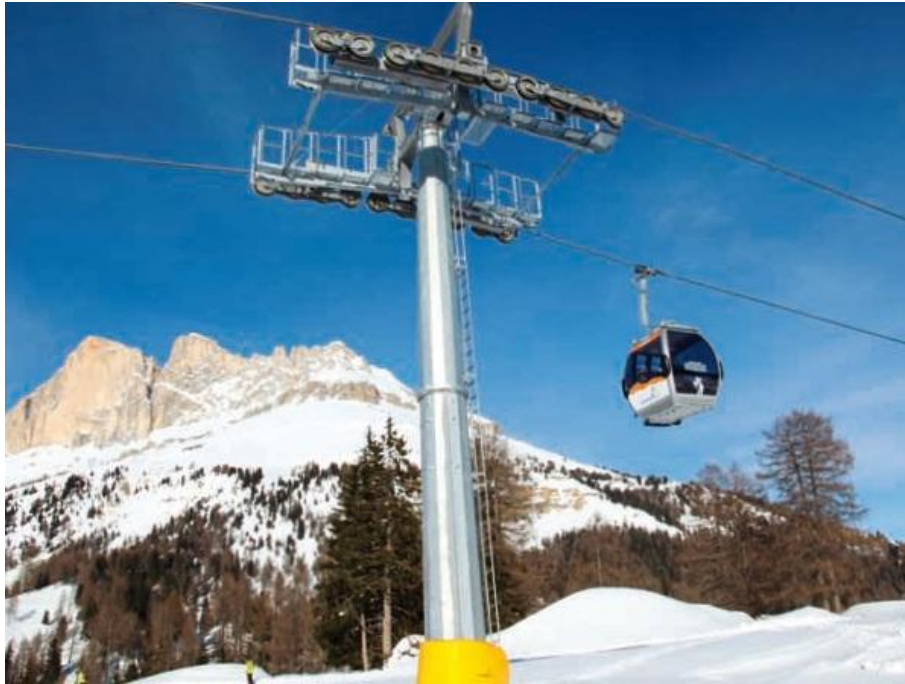
Figura 16. Apoyo de la línea.
