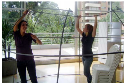
Figura 101. Ensamble de la estructura de la carpa.
