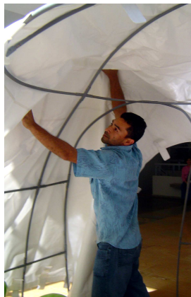
Figura 102. Instalación lona de la carpa. Elaboración propia
