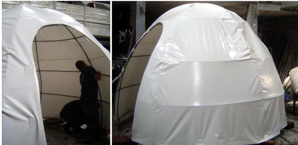
Figura 80. Instalación de la lona en la estructura Elaboración propia.
