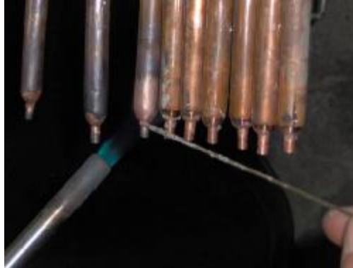
Ilustración 62 Soldadura termopozos
