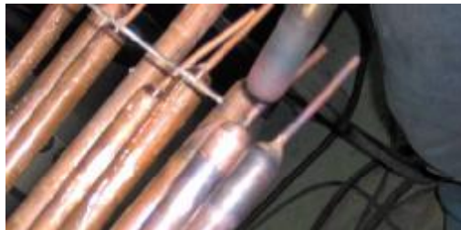
Ilustración 61 Soldadura capilares
