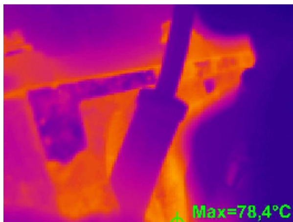
Ilustración 38 Termografía exterior bujías
