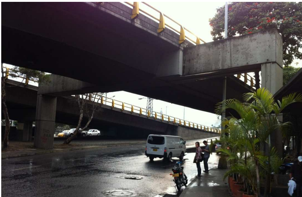
Figura 4.3. Subestructura de viaducto que permite el flujo vehicular bajo la superestructura.
