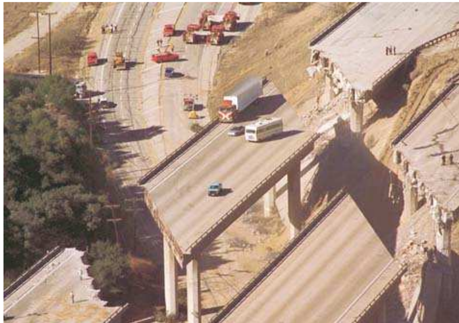
Figura 1.3. Daño en puente por el Sismo de Northridge. Enero 14 de 1994 (Mitchell, 2006)
