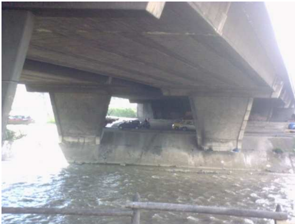
Figura 6.17. Foto con la estructuración de la superestructura
