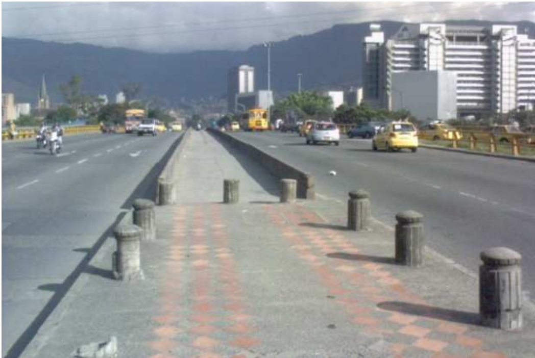
Figura 6.18. Panorámica del puente vehicular de la avenida San Juan sobre el río Medellín
