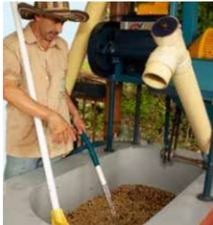
Figura 18. Tanques de fermentación en concreto, plástico o acero inoxidable para la descomposición del mucílago
