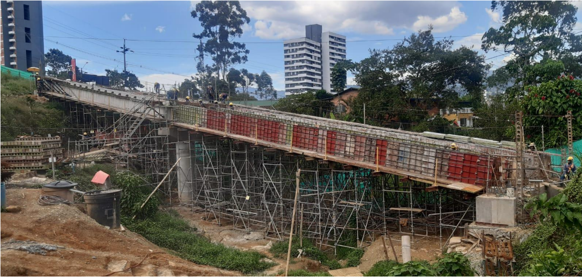
Fig. 28. Obra falsa para caso de estudio 3.
