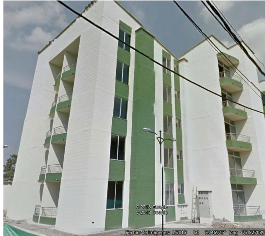
Imagen 2.4 Edificio en mampostería reforzada dúctil en Barrancabermeja. Fuente: Google Streetview, Barrancabermeja (2018).
