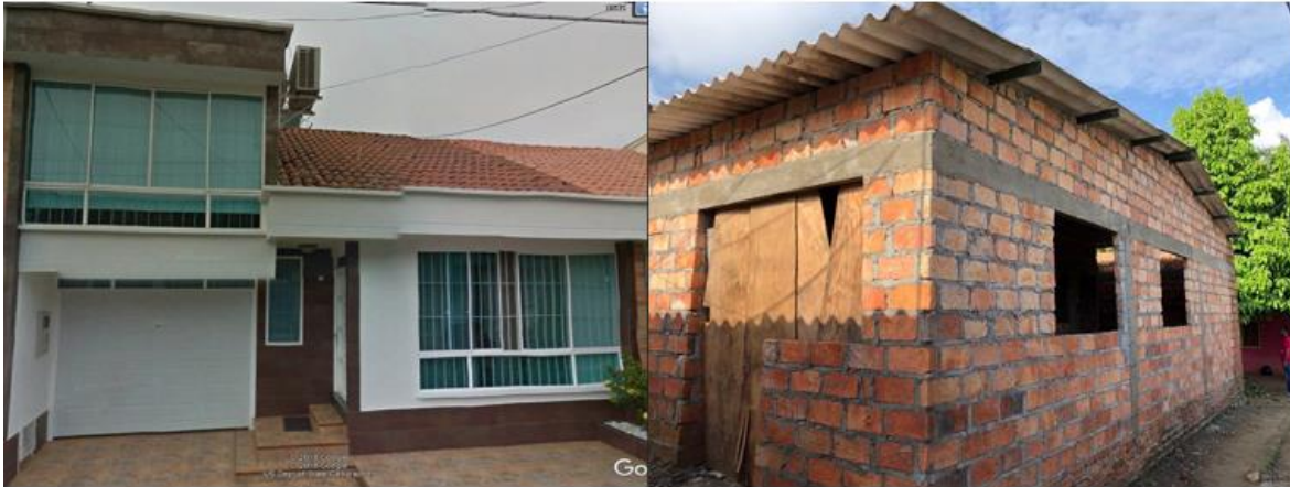
Imagen 2.3 Casa de mampostería confinada dúctil (Izquierda). Casa en mampostera confinada no dúctil (Derecha).
