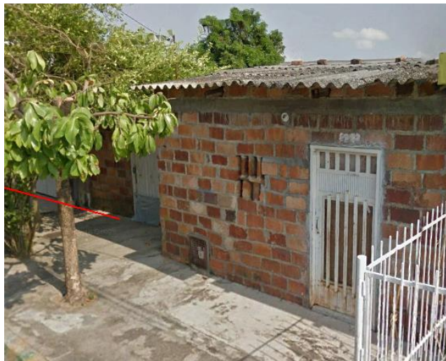
Imagen 2.5 Mampostería no reforzada. Fuente: Google Streetview, Barrancabermeja (2018).
