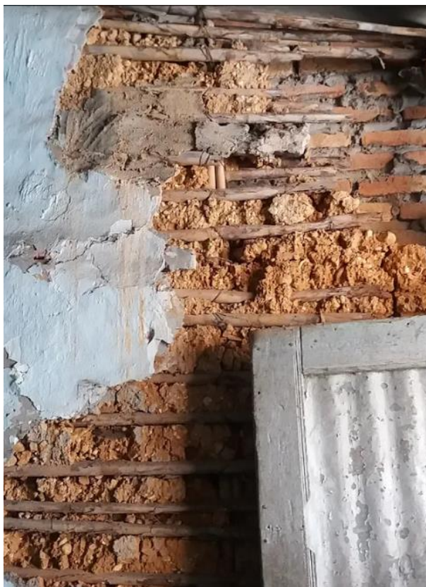
Imagen 2.2 Muros de Bahareque Fuente: Elaboración propia.
