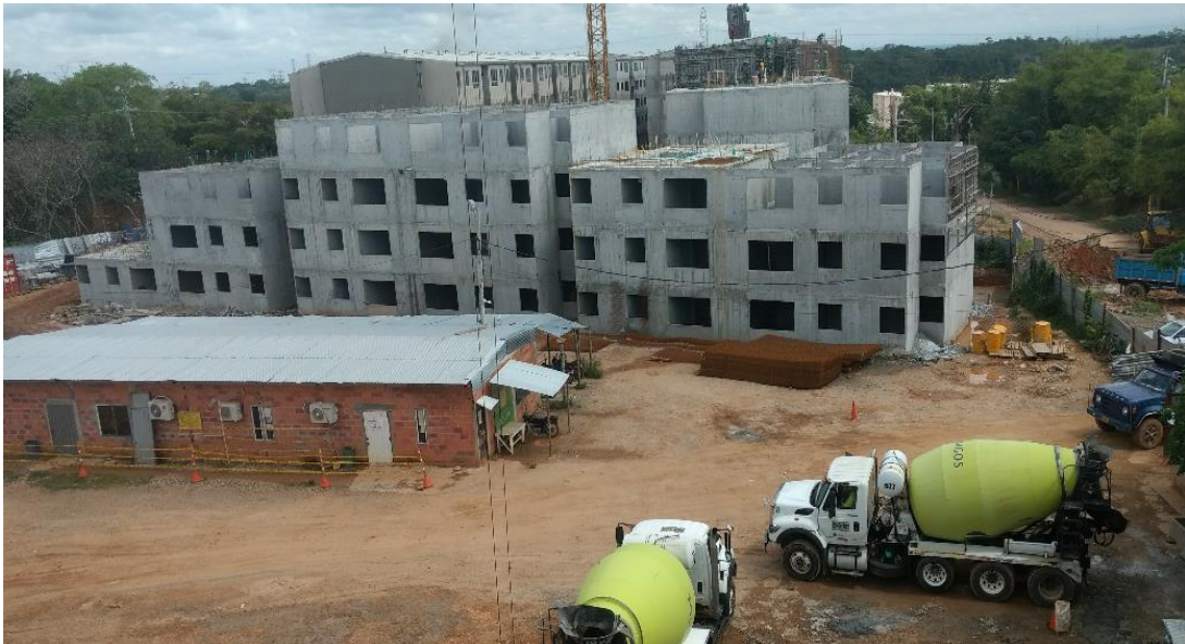
Imagen 2.6 Muros vaciados en concreto reforzado. Fuente: Google Streetview, Barrancabermeja (2018).
