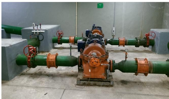
*Ilustración 7. Motobombas superficie existentes bombeo Caldas-Paraíso.*
