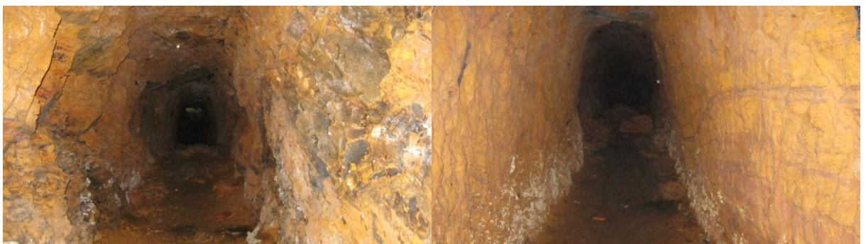
Figura 89. Minas en socavón para la explotación aurífera ubicadas cerca a la sede forestal de la universidad Nacional.
