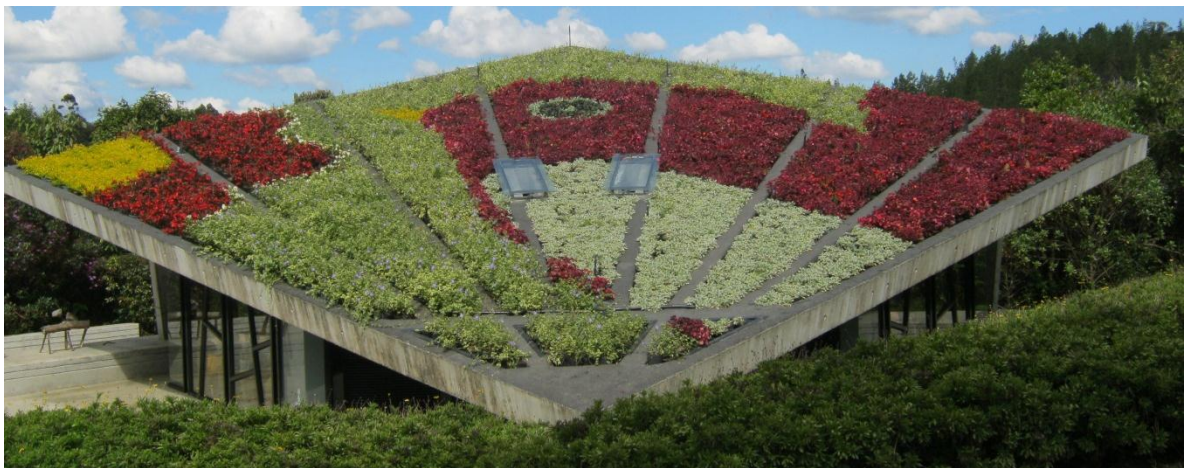
Figura 97. Construcción en concreto dentro del núcleo de Comfama.
