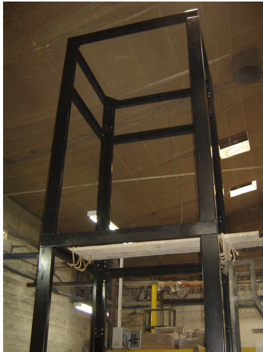
Figura 44: Estructura completa de dos niveles
