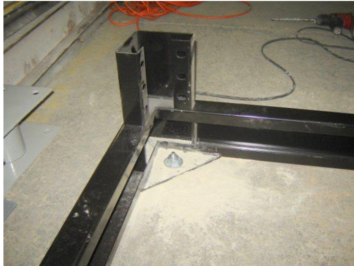
Figura 40: Detalle de la base y el anclaje a piso
