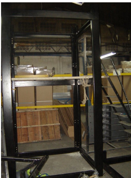
Figura 43: Primer módulo de columnas con anillo
