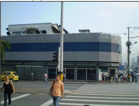
Foto 75. Falta semáforo peatonal. Fuente: elaboración propia.
