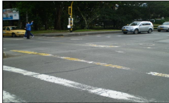
Foto 12. Estado de la pintura. Fuente: elaboración propia.
