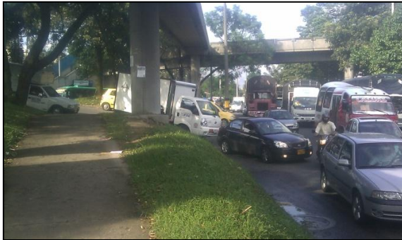
Foto 64. Oreja proveniente de la calle 12 sur. Fuente: elaboración propia.
