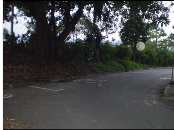
Foto 63. Ubicación del terraplén. Fuente: elaboración propia.
