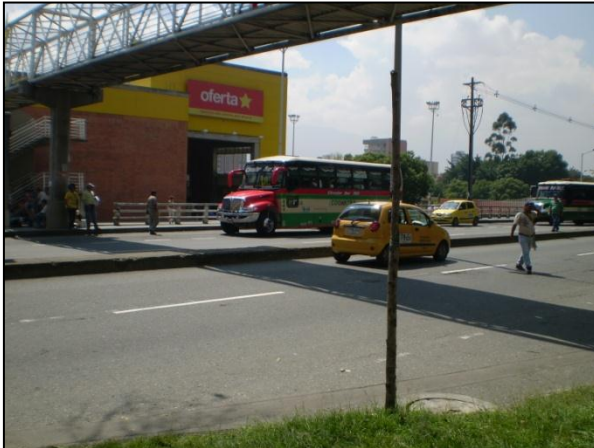
Foto 81. Peadones que no utilizan el puente. Fuente: elaboración propia.
