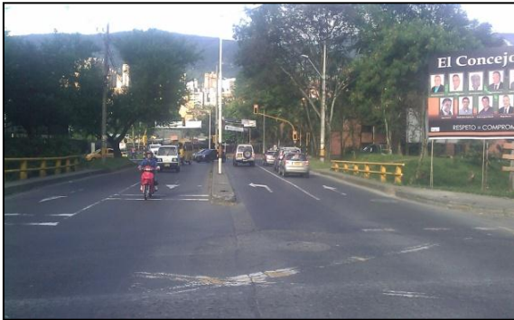
Foto 11. Estado de la pintura. Fuente: elaboración propia.
