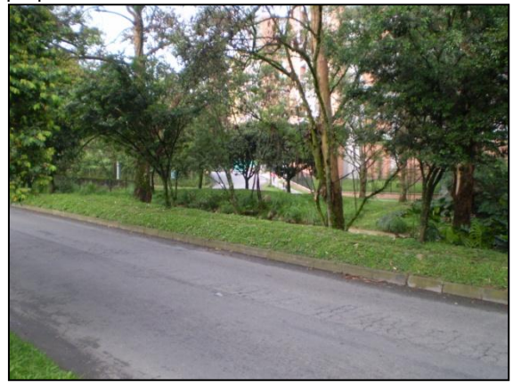
Foto 10. Costado calle 24B sur sentido oriente – occidente, puente oriental. Fuente: elaboración propia.
