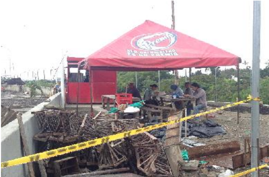
Figura 36. Zona de alimentación obra E401
