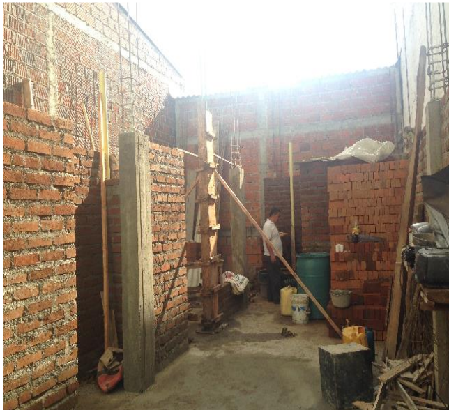
Figura 28. Obra 3. Aspectos de la obra
