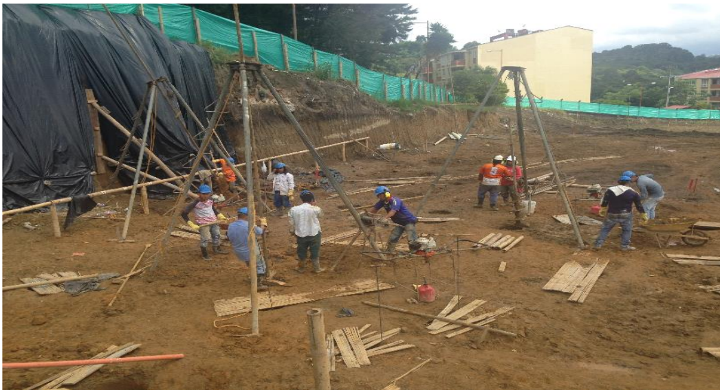
Figura 30. Aspecto general de la obra
