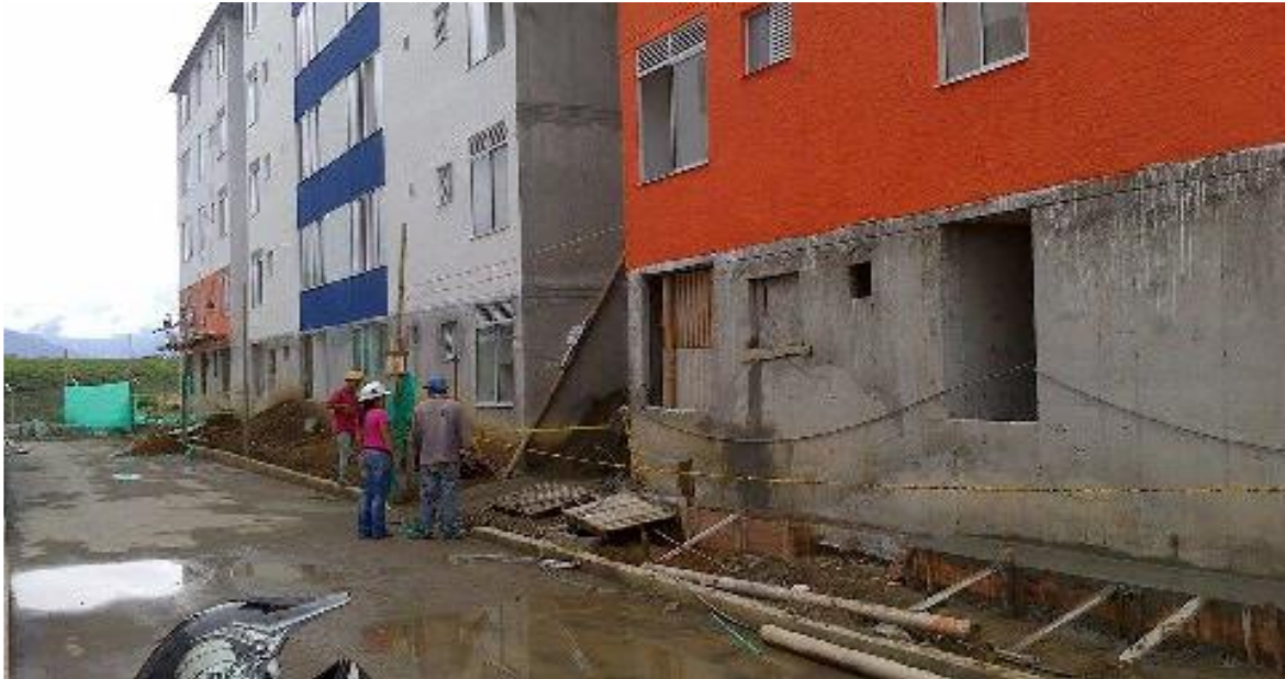
Figura 37. Vista general de la obra E4O2
