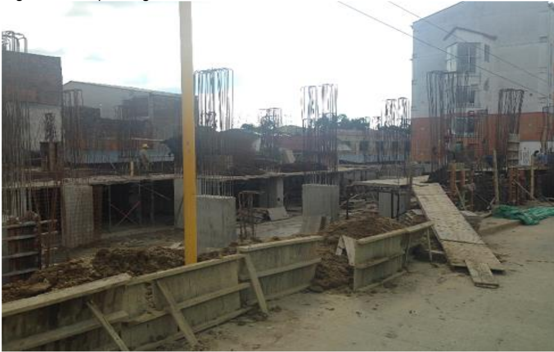
Figura 42. Aspecto general Obra E502
