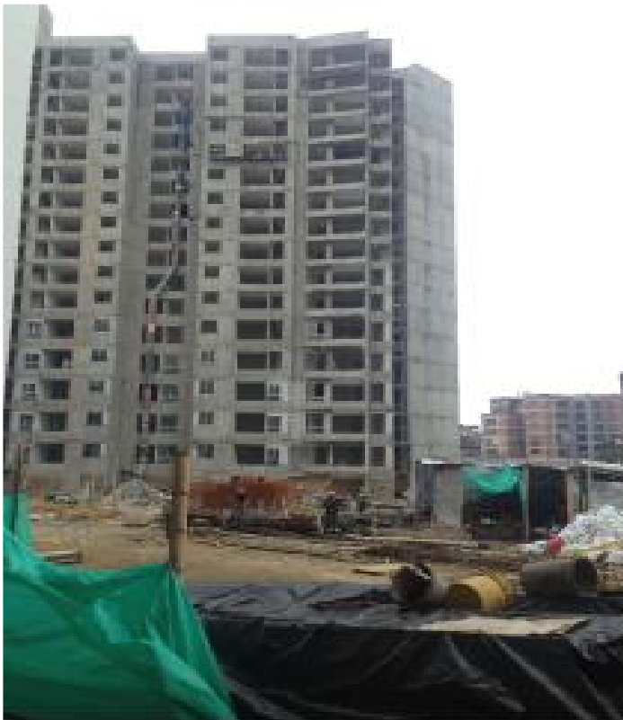
Figura 26. Vista general apartamentos obra E2
