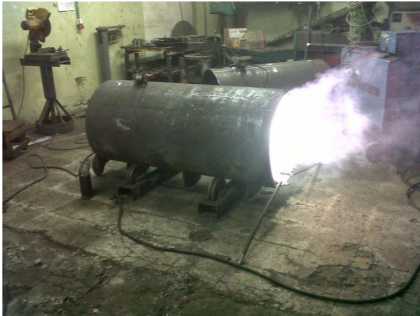
Foto 7. Soldadura de tubería en el interior.
