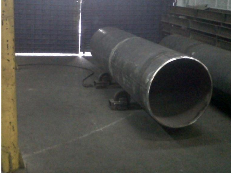
Foto 6. Ensamble de tubería.
