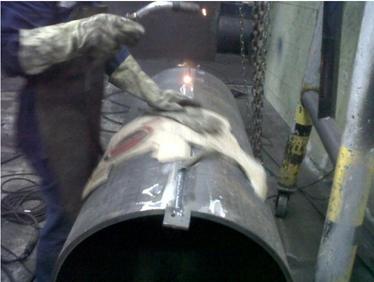
Foto 8. Soldadura de tubería en el exterior.
