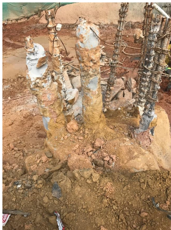
Fig. 16. Exhumed micropiles.
