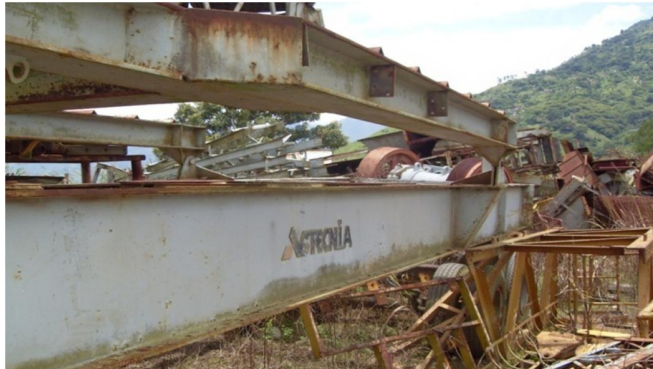
Ilustración 12. Planta secundaria de trituración Astecnia.
