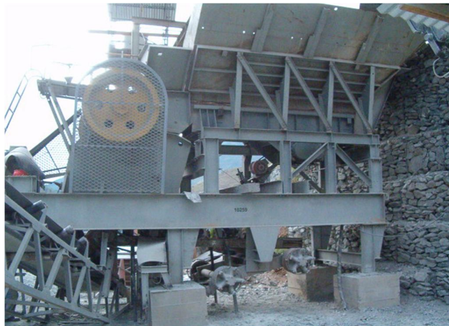
Ilustración 24. Montaje de la primaria de trituración Astecnia.
