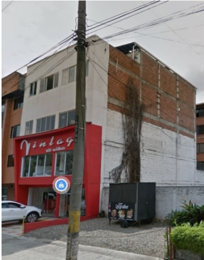
Fig 24. Edificación de pórtico con muros de relleno de ductilidad baja presente en la ciudad de Santiago de Cali, © Google 2022.
