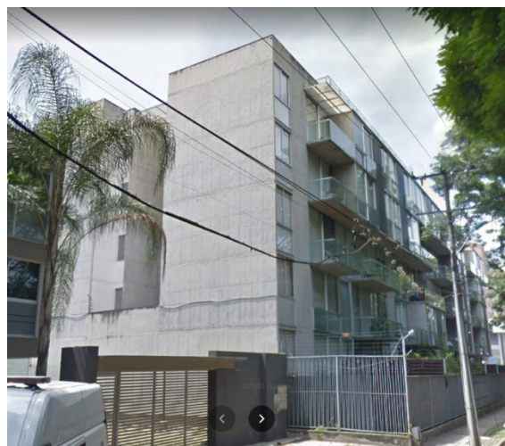
Fig 27. Edificación con muros de hormigón reforzado y alta ductilidad situada en Santiago de Cali, © Google 2022.
