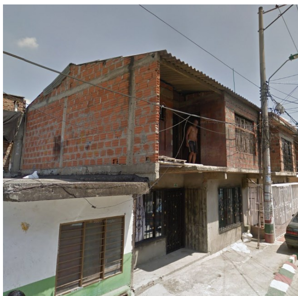
Fig 32. Edificación de mampostería confinada con ductilidad baja presente en la ciudad de Santiago de Cali, © Google 2021.
