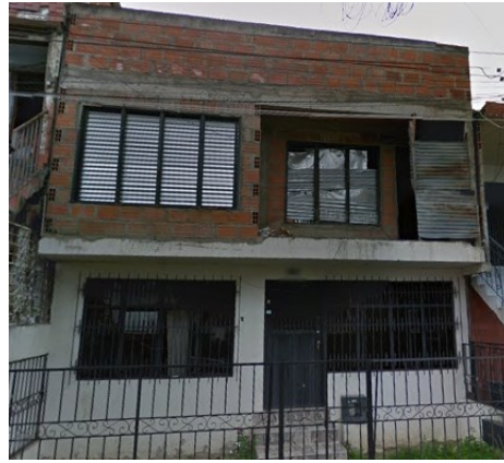
Fig 29. Edificación de mampostería no reforzada sin ductilidad de la ciudad de Santiago Cali, © Google 2021.
