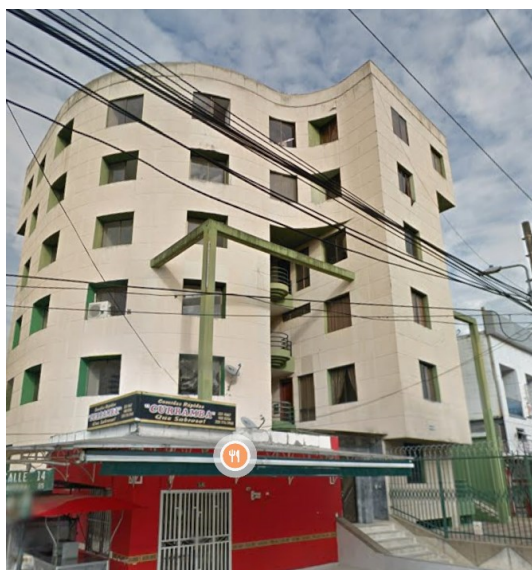
Fig 22. Edificación de pórtico con ductilidad baja presente en la ciudad de Santiago de Cali, © Google 2022.
