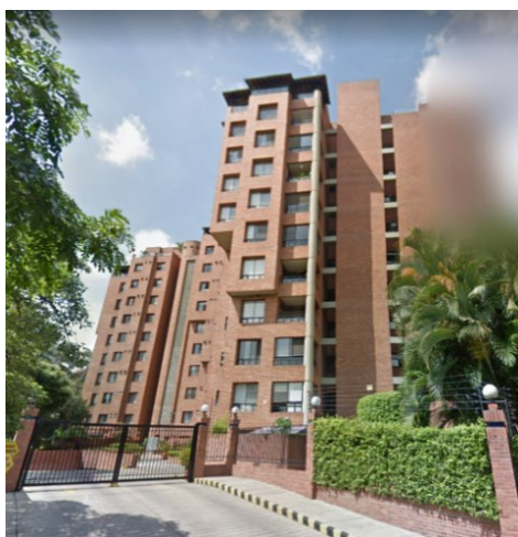
Fig 23. Edificación de pórtico con ductilidad alta presente en la ciudad de Santiago de Cali, © Google 2021.
