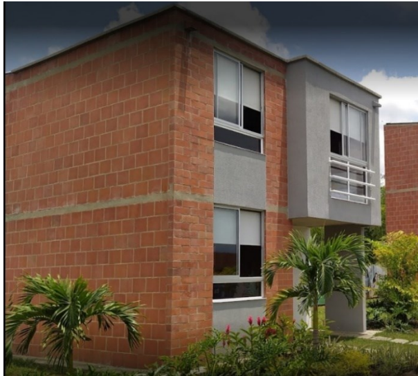
Fig 31. Edificaciones de mampostería reforzada con ductilidad alta en Santiago de Cali, © Google 2021.
