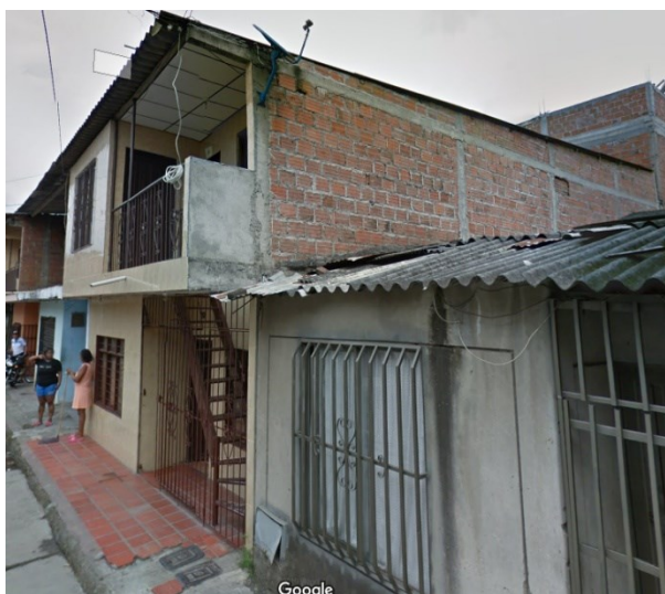
Fig 33. Edificación de mampostería confinada con ductilidad media presente en la ciudad de Santiago de Cali, © Google 2021.
