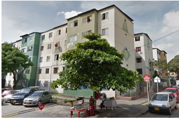
Fig 26. Construcción con muros de hormigón reforzado y ductilidad media localizada en Santiago de Cali, © Google 2021.
