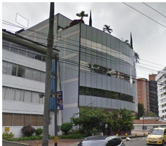
Fig 25. Edificación de pórtico con muros de relleno de ductilidad alta presente en la ciudad de Santiago de Cali, © Google 2021.
