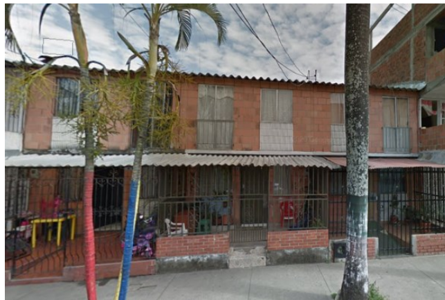
Fig 30. Edificaciones de mampostería reforzada con ductilidad baja en Santiago de Cali, © Google 2022.
