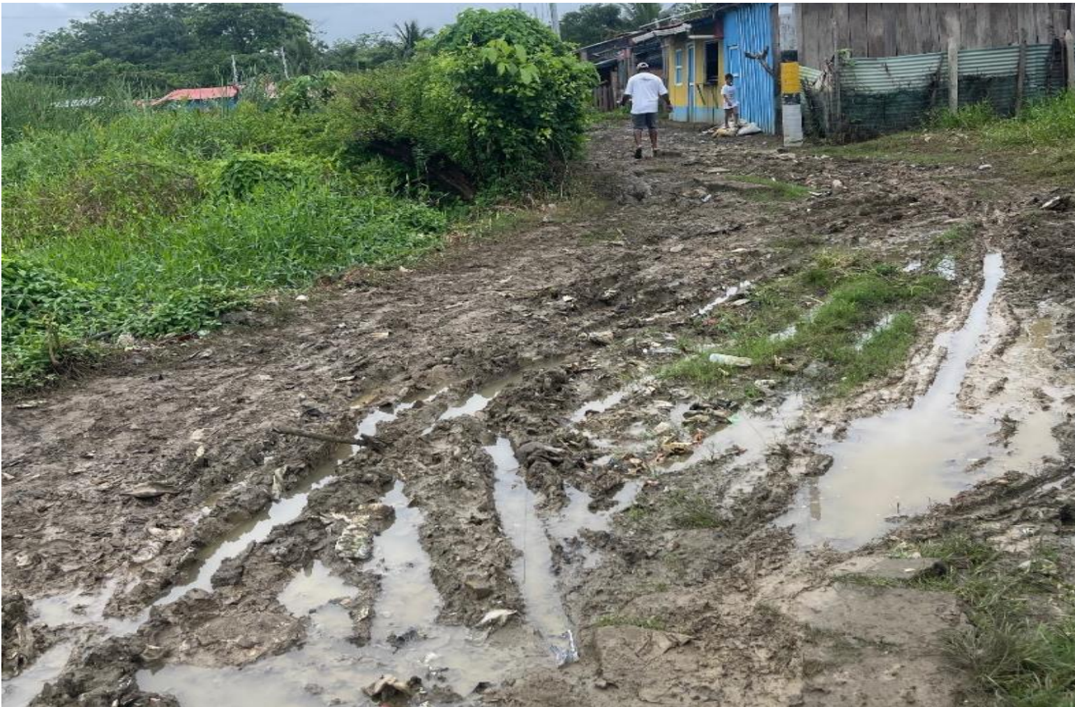
Figura. 6 Estado de vías en época de lluvias
