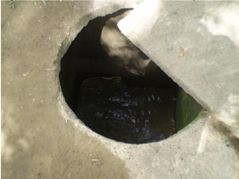
Figura 27. Cámara 2 entre desarenadores 1 y 3.
