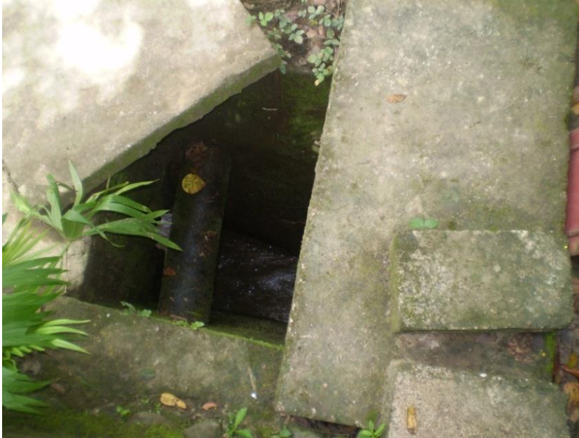
Figura 26. Cámara 1 entre desarenadores 1 y 3.
