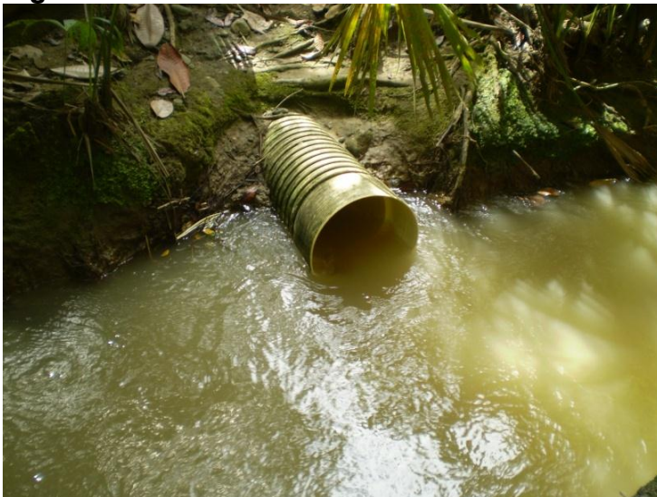
Figura 20. Conducción de canal a desarenador 3.
