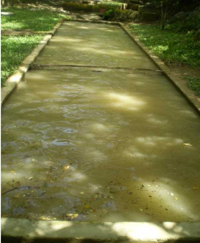
Figura 28. Desarenador No. 3 (principal)
