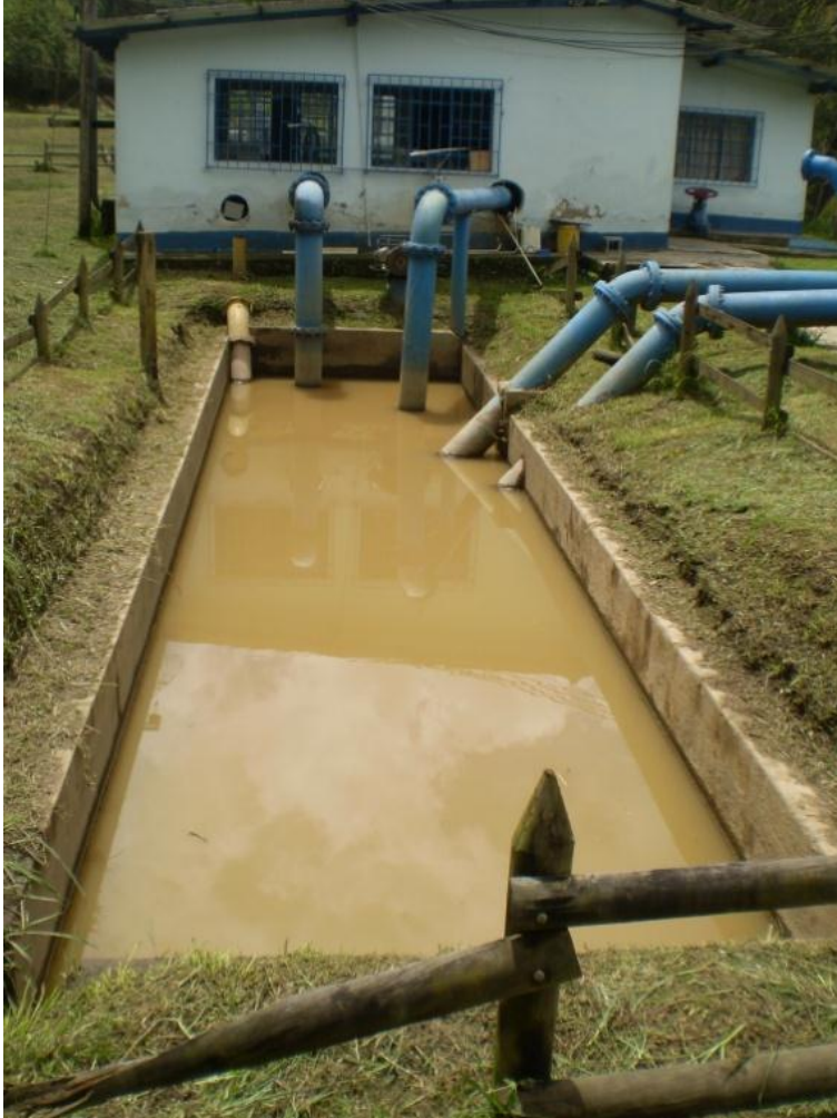
Figura 42. Tanque de succión y sala de máquinas, quebrada La Bolsa.
