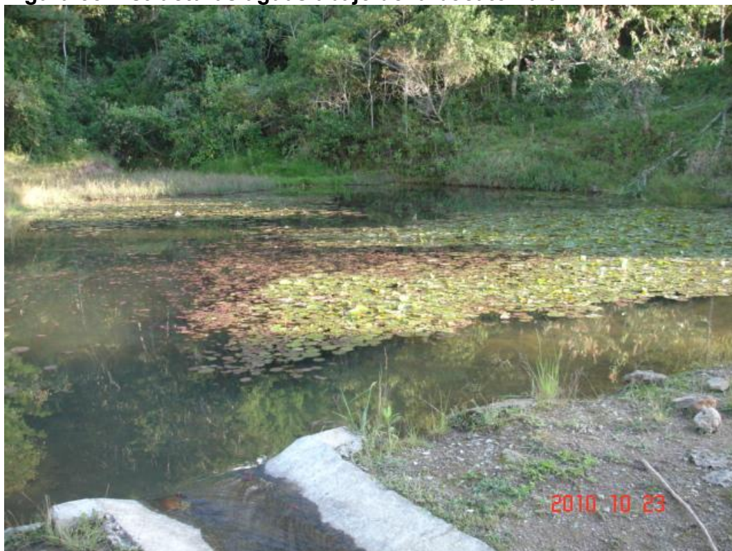
Figura 55. Estructuras aguas abajo de la bocatoma 3.
