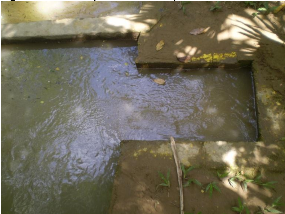
Figura 29. Cámara que conduce a la planta de tratamiento.
