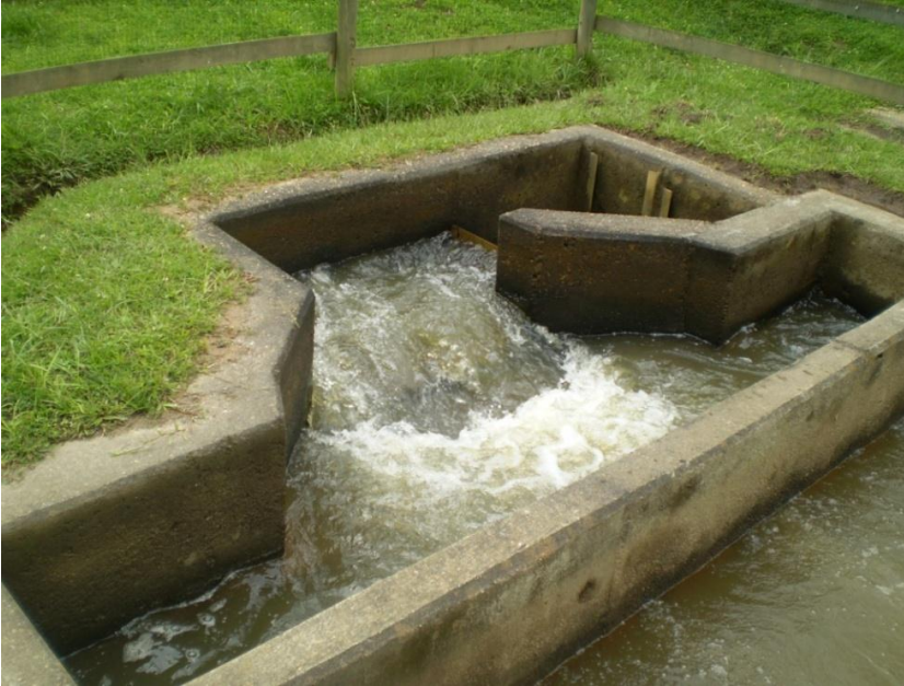
Figura 40. Cámara de aquietamiento, quebrada Barbacoas.
