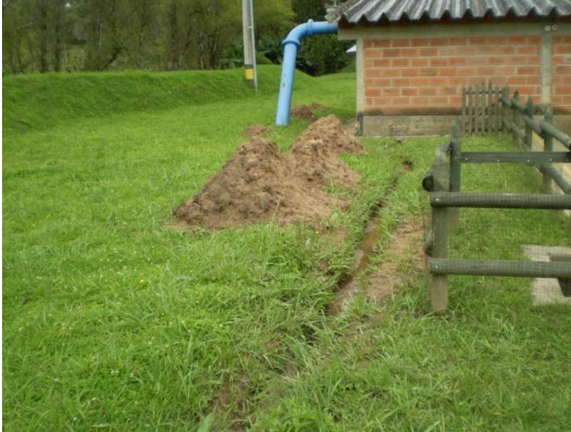
Figura 43. Jarillones de limo arcilloso en bocatoma quebrada Barbacoas.
