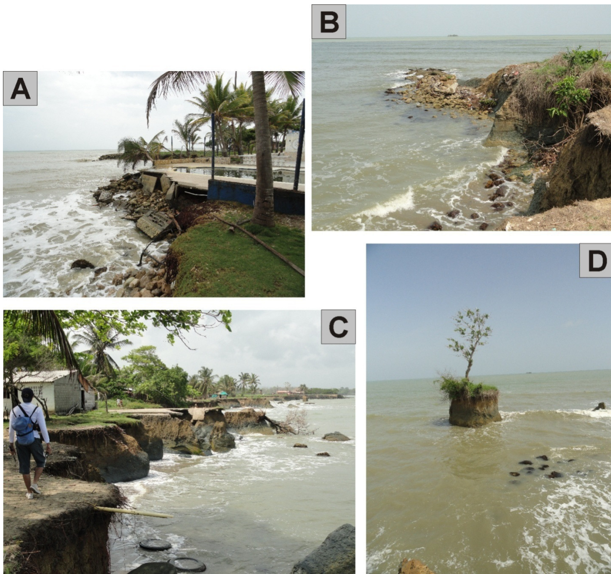
Figura 3.11. Remanentes erosivos y afectación de viviendas presentes en los acantilados entre Puerto Rey y Arboletes. (A) Casa de recreo abandonada en la actual Punta Rey; (B) espolón sin ganancia de playa en su zona de acumulación, con la Isla Rey en el centro-arriba de la fotografía; (C) pérdida acelerada de terrenos en el barrio Minuto de Dios; (D) remanente erosivo ( stack ) al sur del barrio Minuto de Dios, con Isla Rey en el fondo. Fotografías tomadas el 17 de mayo de 2012 por Iván D. Correa.
