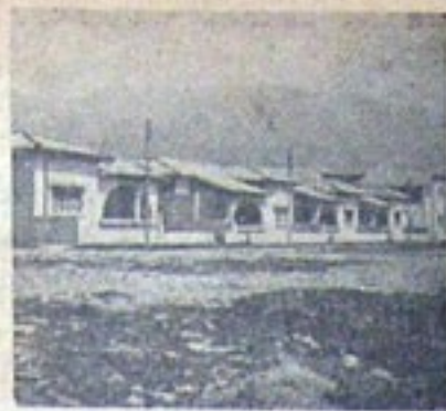
CASAS PARA OBREROS
